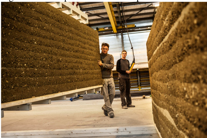
Figura 5 – Placa pré-moldada em taipa
