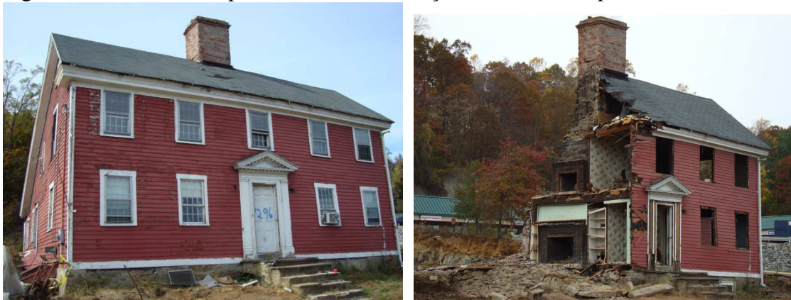
Figuras 2 e 3 – Antes e após o início da demolição da The Oronoque saltbox , 2012
