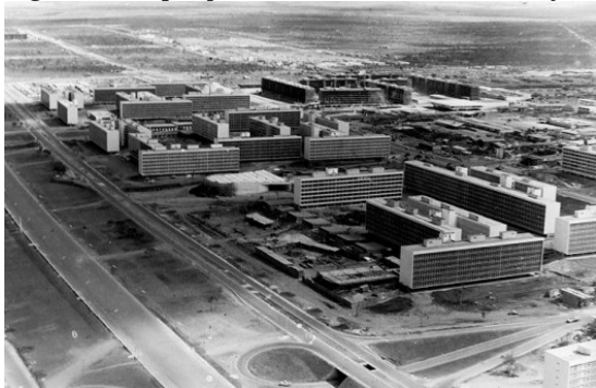
Figura 8 – Superquadra da Asa Sul em construção
