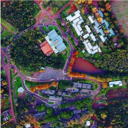
Figura 4 - Vista aérea da Instituição
